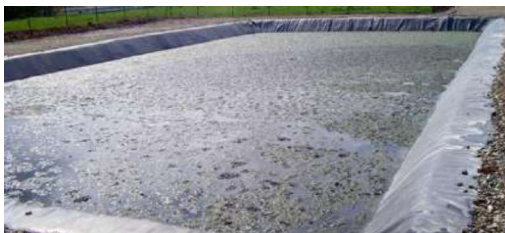
Exemple de lagune pour stockage de digestat liquide
